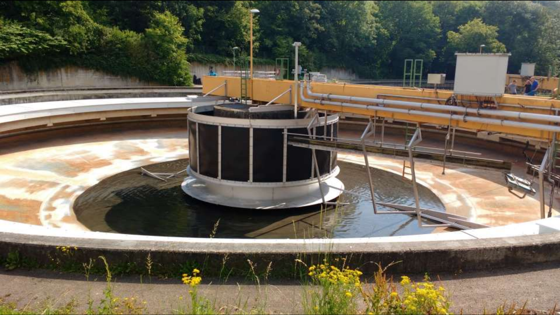
Anspruchsvolle Nachrüstungen: höhenverstellbare Einlaufschürze
